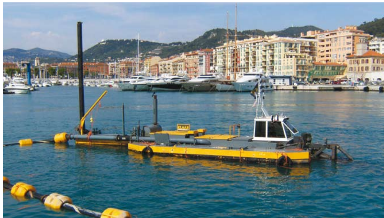
‘Baggerwerkzaamheden in de Franse havenstad Nice’
