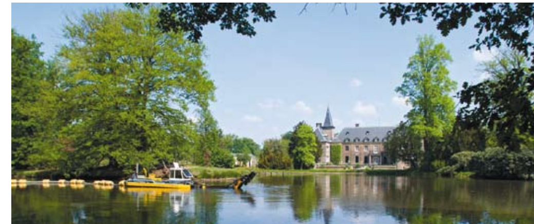
Baggerwerk op het landgoed Twickel te Delfland
