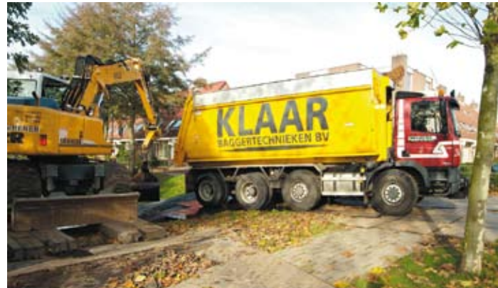
Het laden van baggerspecie in een waterdichte baggercontainer
