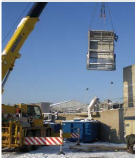
Montage roostergoed reiniger
