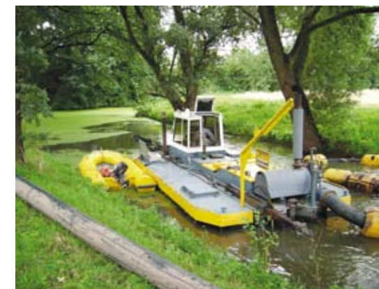
Baggeren met kleine zuiger in de stadsgrachten van Doesburg voor het waterschap Rijn en IJssel
